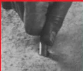
Bei Innengewindedübeln wie HKD und TDD wird die Gewindestange eingedreht. Beim HSL ist die Schraube durch die Gewindestange zu ersetzen.
