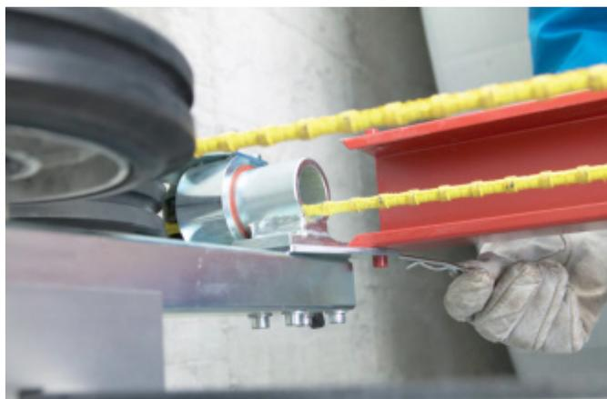
Sécuriser la tôle de protection à l'aide des ligatures de sécurité
