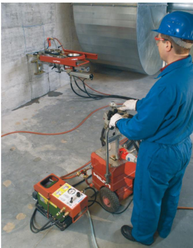
Mettre le mécanisme d'entraînement principal DS WS10-E en marche et laisser le câble diamant démarrer.
