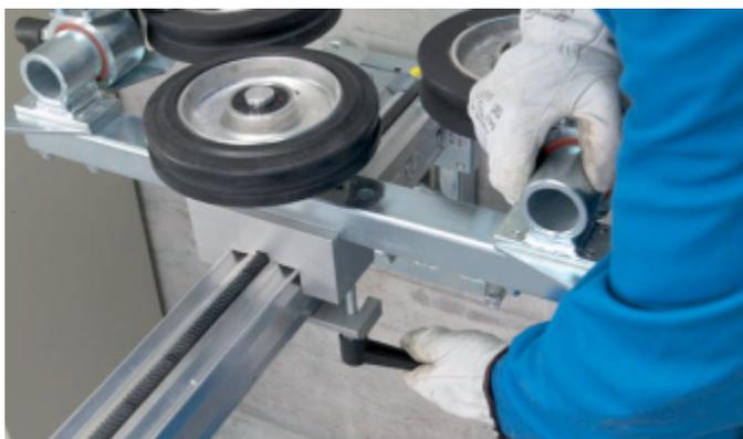
Fermer l'éclisse de fixation et serrer à fond le levier de serrage.
