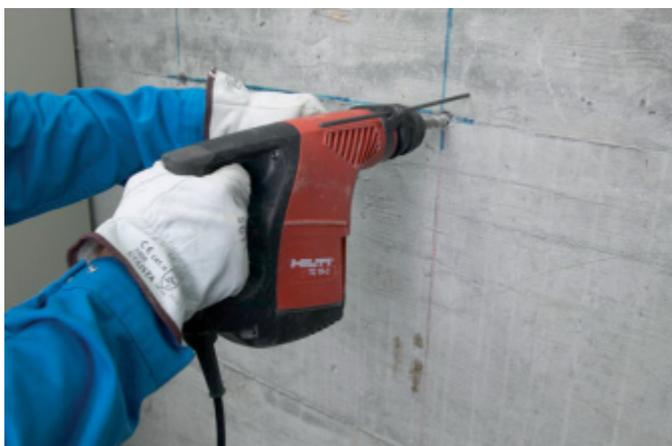
L'emplacement et la position des trous de passage du câble a un impact direct sur la précision de l'entaille. Dans le cas de murs épais ou de tolérances admissibles élevées, il est par conséquent recommandé de percer des trous à l'aide d'un appareil de forage diamant guidé sur support.
