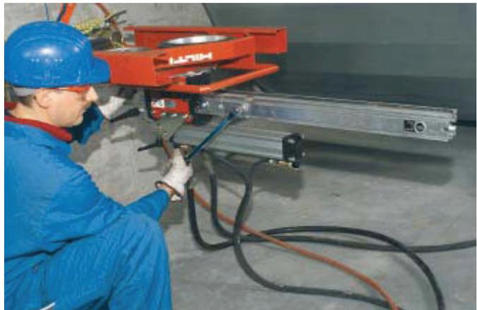
Empuje la extensión al cono de conexión y asegúrelo con el bulón excéntrico.
